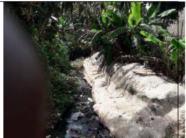
Magasins construits en dur avec des agglos et des baraques pour le petit commerce contigu au collecteur Kôkô SARI (A03) à Bouaké
