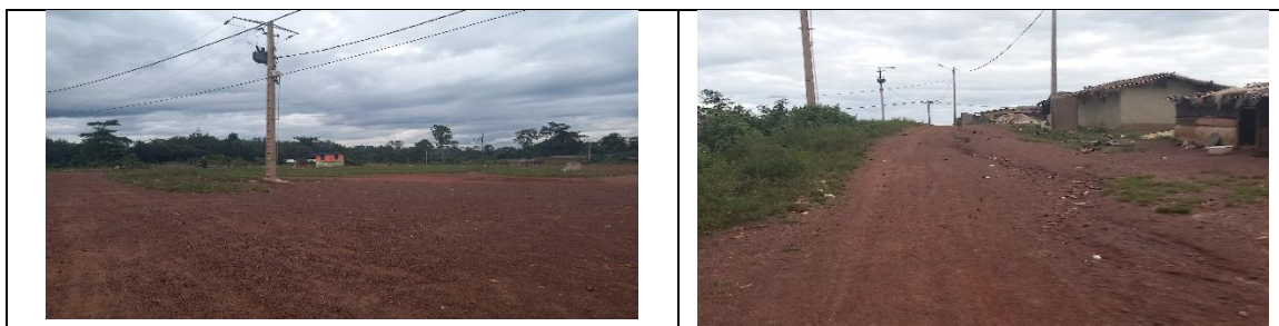
Planche 7: Vue d'équipements électriques à AOUTTOUKRO
