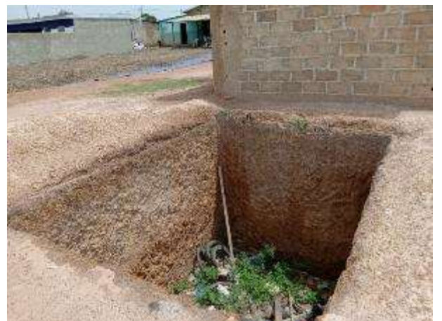
Photo 15: Visite de la fosse septique inachevée de la nouvelle gare de Minignan
