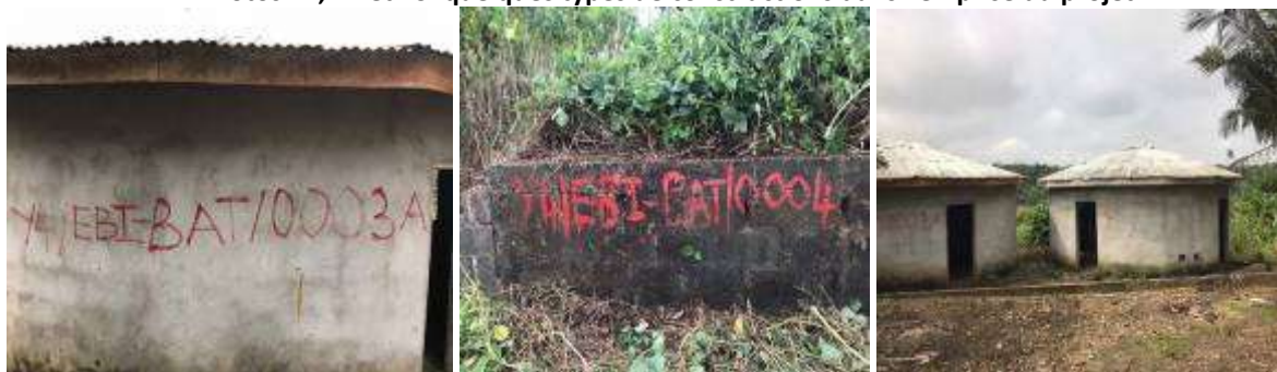
Photos 21, 22 et 23: quelques types de constructions dans l'emprise du projet
