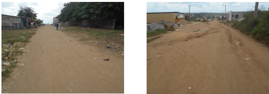
Photo 1 : vues de l'emprise de la conduite de refoulement du centre de traitement vers le château d'eau
