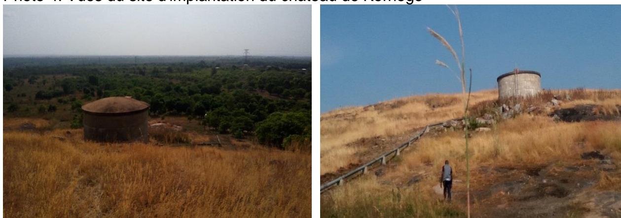
Photo 4: Vues du site d'implantation du château de Korhogo
