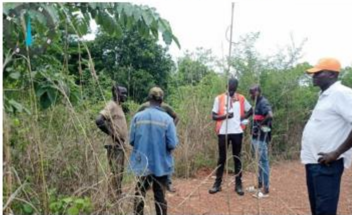
Visite de l'emprise des travaux avec les exploitants agricoles
