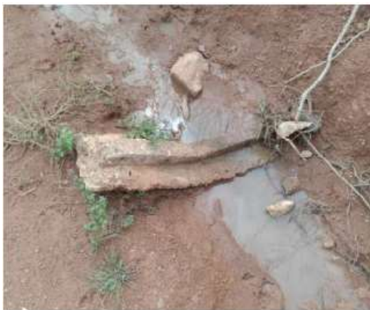
Dégradation du béton du drain de pied de la digue
