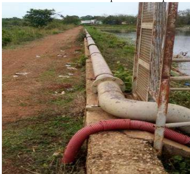
Photo 4: Vue de la conduite d'aspiration de la prise d'eau
